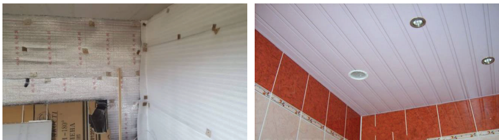
Зураг 41. Хувийн сууцны гадна, дотор дулаалгад хөөсөнцөр хавтан, полиэстер, пластмаст зэрэг материалыг ашиглаж байгаа байдал
