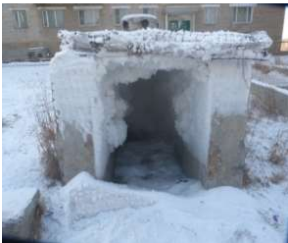
1-р зураг. Одоо орж байгаа хойд хаалга. Баруун гарцыг бетоноор тагласан
