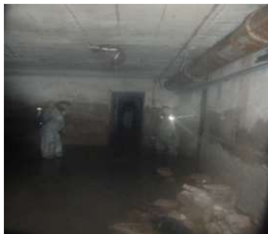
6-р зураг. Хоргодох байрны төв коридор болон бусад өрөөнд ус тогтсон байдал
