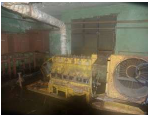
2-р зураг. Нөөц цахилгаан үүсгүүр, цахилгааны щитээр тоногдсон байдал
