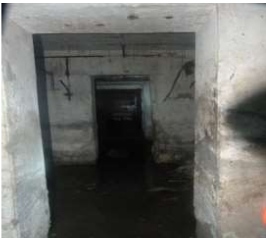
6-р зураг. Хоргодох байрны төв коридор болон бусад өрөөнд ус тогтсон байдал
